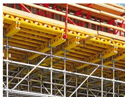
Для опалубивания с использованием балки-фермы GT 24 требуется меньшее количество балок и стоек перекрытий. Это приводит к экономии затрат как на материалы, так и на рабочую силу.
