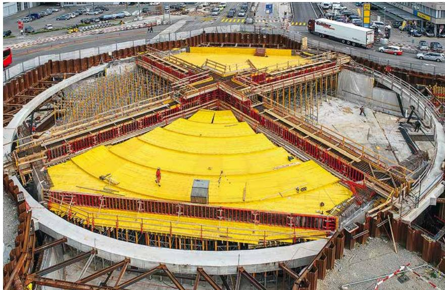
**MULTIFLEX** может использоваться с любым видом фанеры. В зависимости от требований, касающихся частоты использования и качества нижней поверхности перекрытия, на опалубочные балки могут быть установлены листы обшивки различного качества и размеров.
