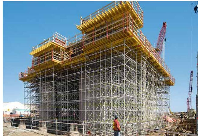
С помощью систем PERI UP Rosett и MULTIFLEX можно было высокие нагрузки массивных строительных элементов с высоты от 10 до 12 м надежно передавать в основание.
