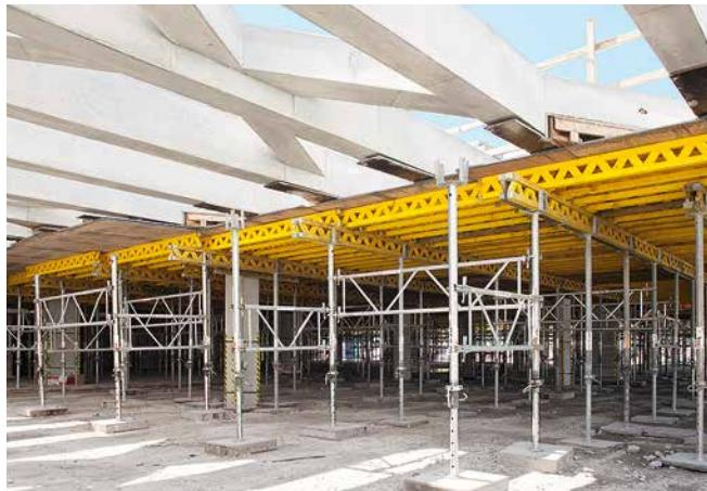
Система MULTIFLEX использовалась для бетонирования на месте балок с помощью стоек PEP, соединенных посредством рам PRK для образования башенных опор.
